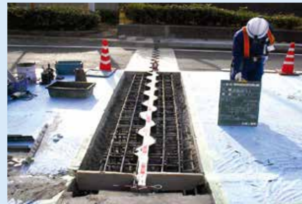
伸縮装置設置
