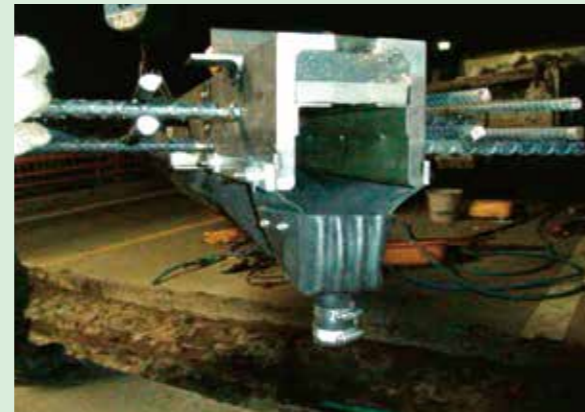
ダブル止水部材取付
