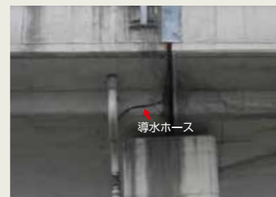
排水管への流末導水処理例
