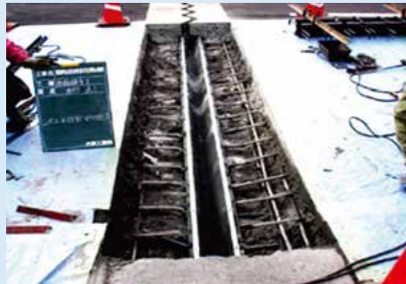
ダブル止水部材取付
