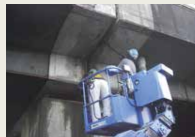
高所作業車での施工例
