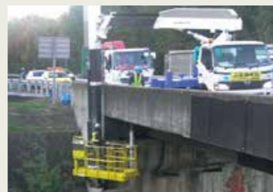
橋梁点検車での施工例
