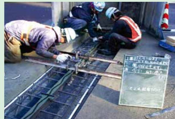
伸縮装置設置
