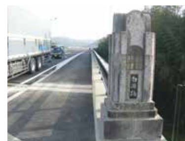
京都府綾部市 白瀬橋
