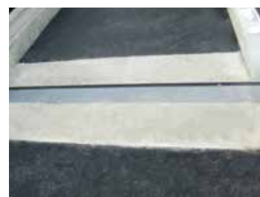
京都府綾部市 白瀬橋
