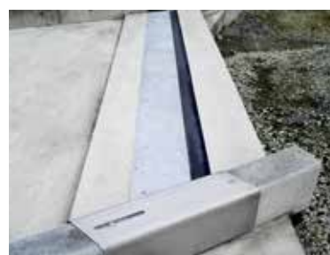
兵庫県西宮市 大西ループ橋
