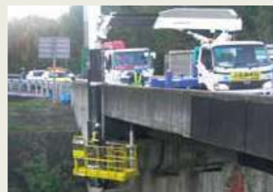
橋梁点検車での施工例
