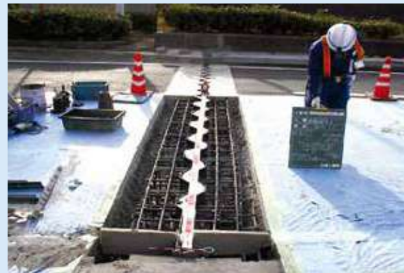
伸縮装置設置
