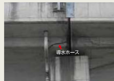
排水管への流末導水処理例
