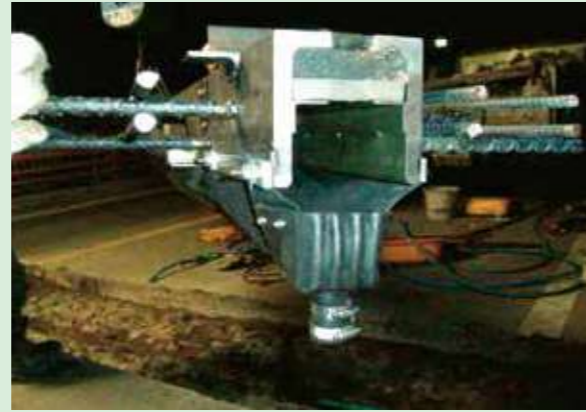
ダブル止水部材取付
