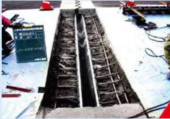
ダブル止水部材取付
