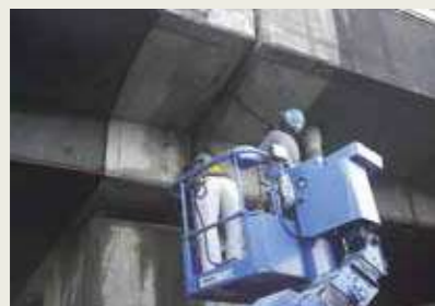
高所作業車での施工例
