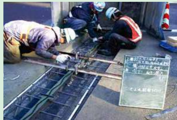
伸縮装置設置
